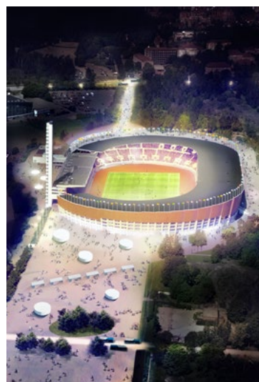
Assemblin Finland har valts som entreprenör för elinstallationerna i samband med ombyggnationen och moderniseringen av Olympiastadion, ett av Helsingfors främsta landmärken.
